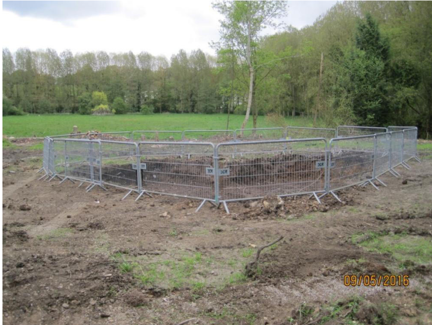
Photo 1 : Prise de vue du site le 9 mai 2016 suite à la première phase d'excavation des terres
